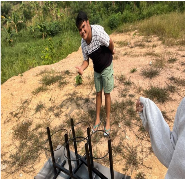
Gambar 5. Pemasangan rangka dudukan tong sampah percontohan di lokasi dusun Desa Lubuk Agung
