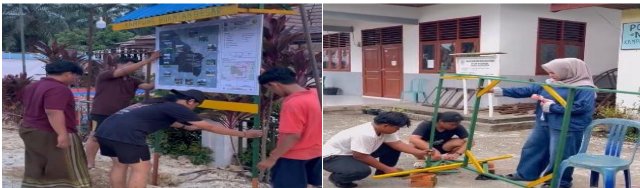
Gambar 3. Proses Pembuatan dan Pemasangan Denah
