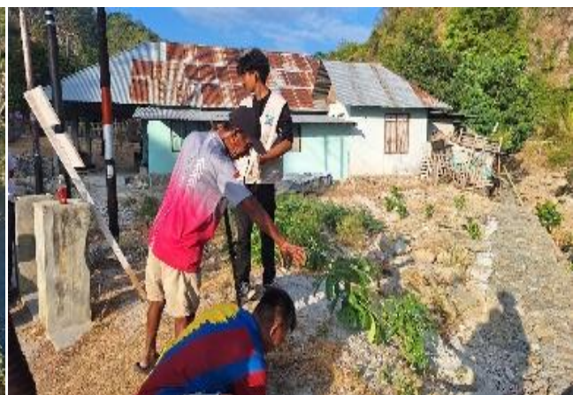
Gambar 4. Pemasangan di Lokasi Ke 3
